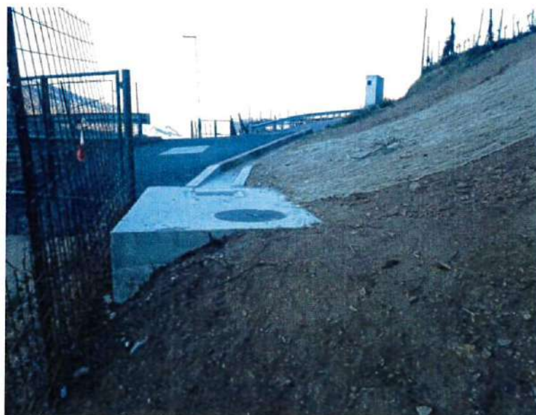
Figura 3: vista della camera di rottura al L.O. di valle, la vori "Tappa 1"
