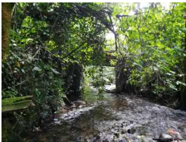
Foto 6: Ponte lato monte
