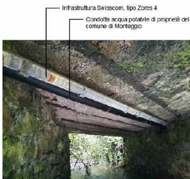
Figura 5: Infrastruttura SWI e condotta AP
