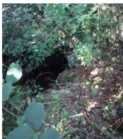
Foto E5: Uscita del torrente Pevereggia dal tubo interrato; il torrente poi scorre fra alti muri in sasso.
