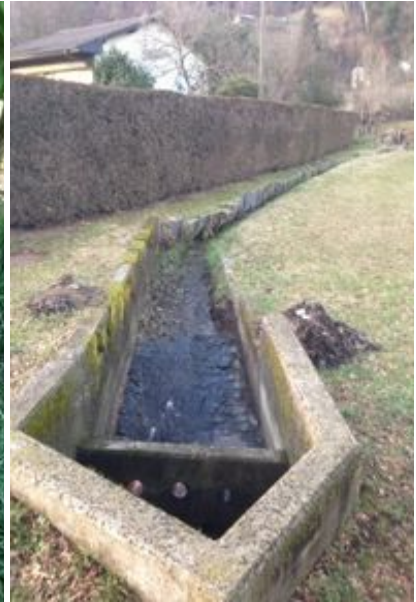
Foto D3: Piccola camera a nord della strada cantonale.
