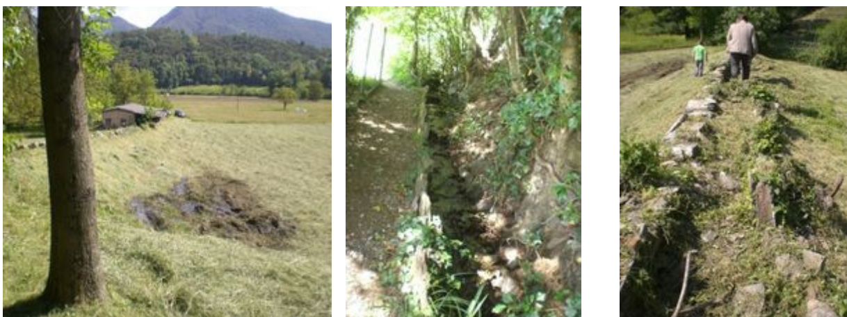
Foto A1-3: A sinistra si scorge il vallo con l'acquedotto in pietra. Le piogge e le perdite, oggi incontrollate, inondano parti del prato che ne rendono difficile la gestione. Nella parte superiore, in bosco, l'acquedotto si è ben conservato (foto in centro); mentre nella parte inferiore il degrado e le perdite non consentono più di portare l'acqua più a valle (foto a destra) che straripa prima.
