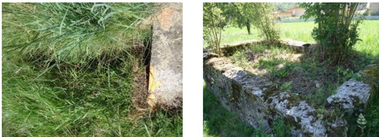
Foto A1-3: A sinistra si scorge il vallo con l'acquedotto in pietra. Le piogge e le perdite, oggi incontrollate, inondano parti del prato che ne rendono difficile la gestione. Nella parte superiore, in bosco, l'acquedotto si è ben conservato (foto in centro); mentre nella parte inferiore il degrado e le perdite non consentono più di portare l'acqua più a valle (foto a destra) che straripa prima.
