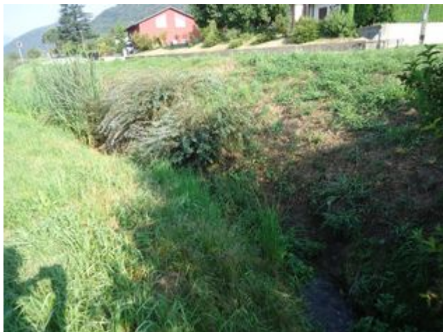
Foto F1: Le acque che arrivano verso questo tratto canalizzato scorrono in ruscelli superficiali lungo la strada cantonale.
