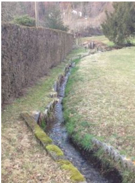
Foto D4: Canale che porta a questa camera che potrebbe essere leggermente ampliato (a destra) per migliorare la sezione idraulica e l'accessibilità per gli anfibi.
