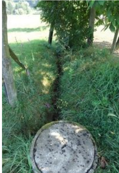
Foto D2: Il percorso superficiale del ruscello finisce in questo tombino; il ruscello diventa interrati.
