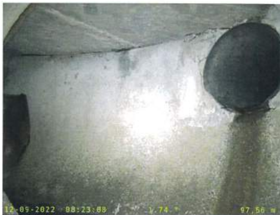
Figura 16 – Vista ingresso in corrispondenza della curva.
