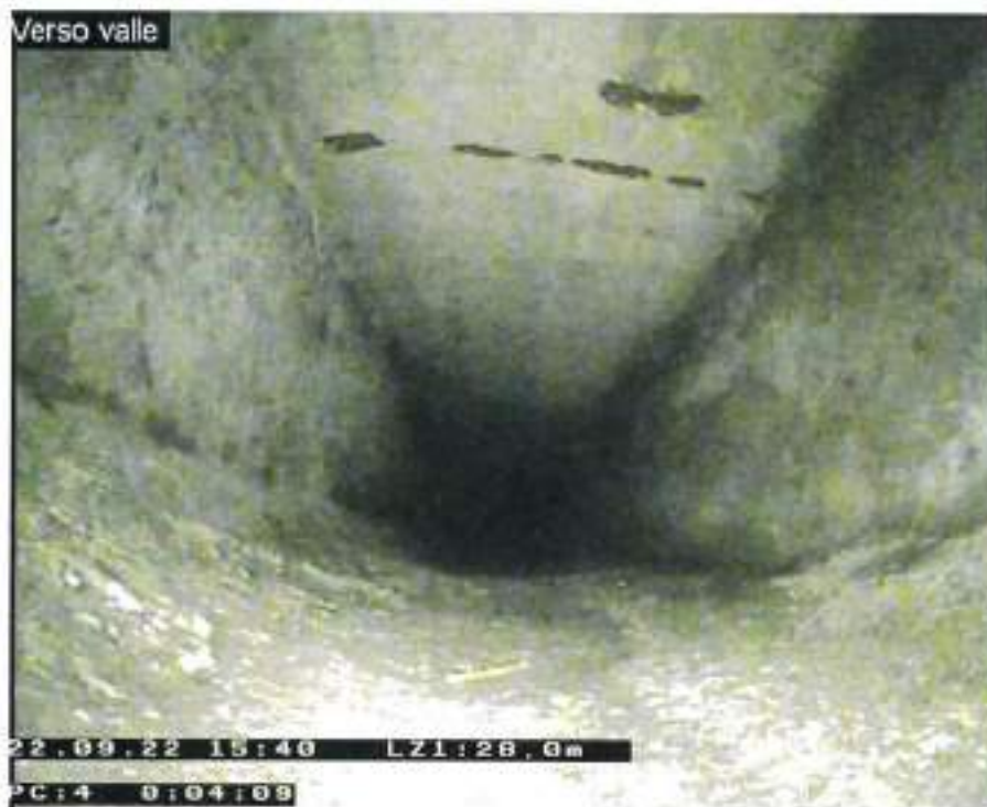
Figura 4 – Vista del condotto a forma scatolare, nel tratto in esame, con fondo consolidato in beton
