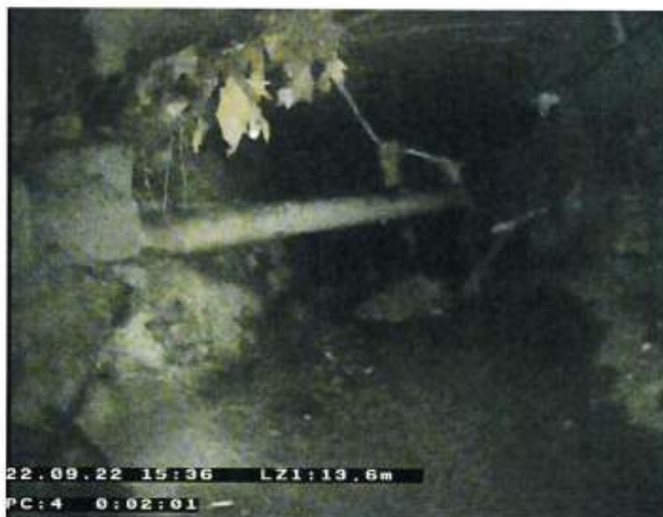
Figura 19 – Vista di un attraversamento trasversale.
