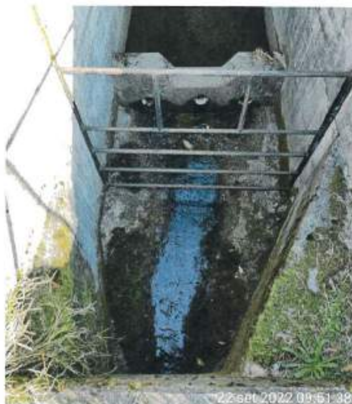
Figura 13 – Vista della griglia a presidio dell'imbocco del tratto intubato del riale Fornasette.
