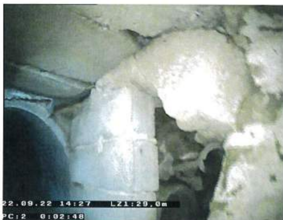
Figura 17 – Vista delle immissioni laterali.
