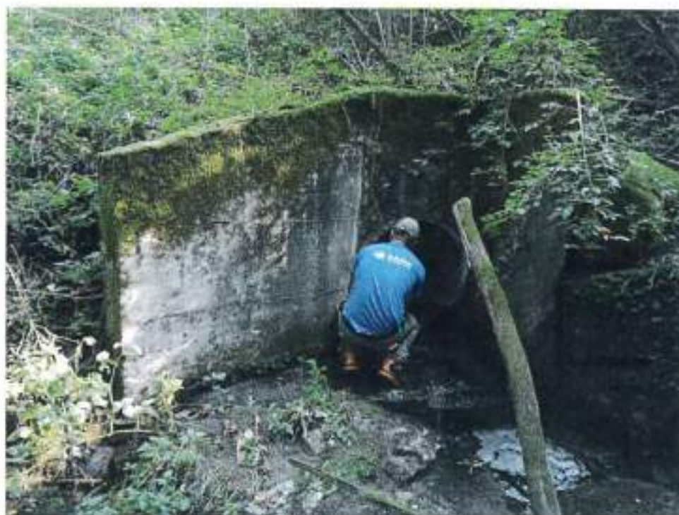
Figura 6 – Vista del manufatto di sbocco
