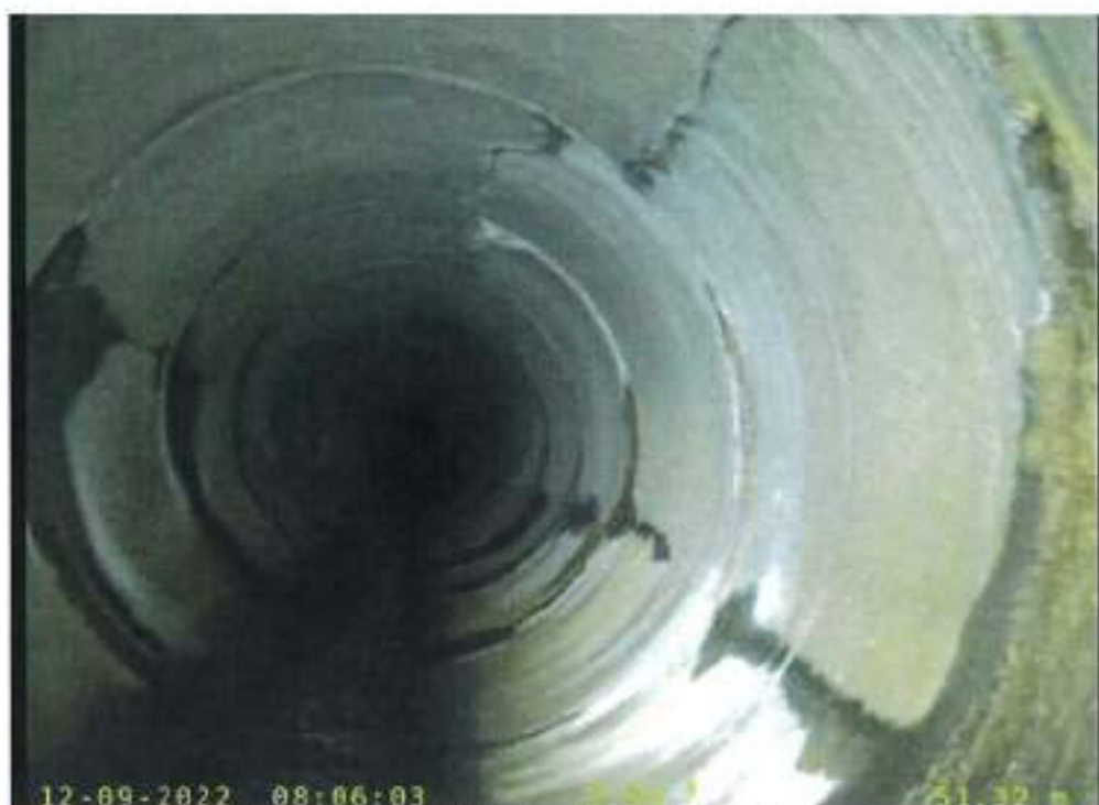
Figura 5 – Vista del circolare, nel tratto in esame
