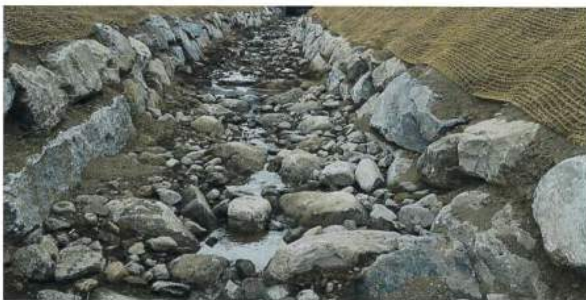
Figura 21 – Esempio di riqualifica ambientale messa in opera a Cadempino.
