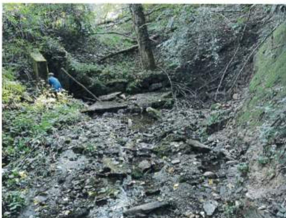
Figura 14 – Vista dello sbocco del riale Fornasette.
